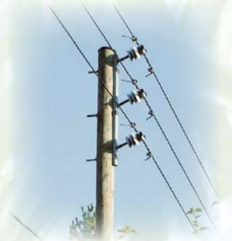
Рис. 6. Система линии электропередачи с использованием защищенных СИП
