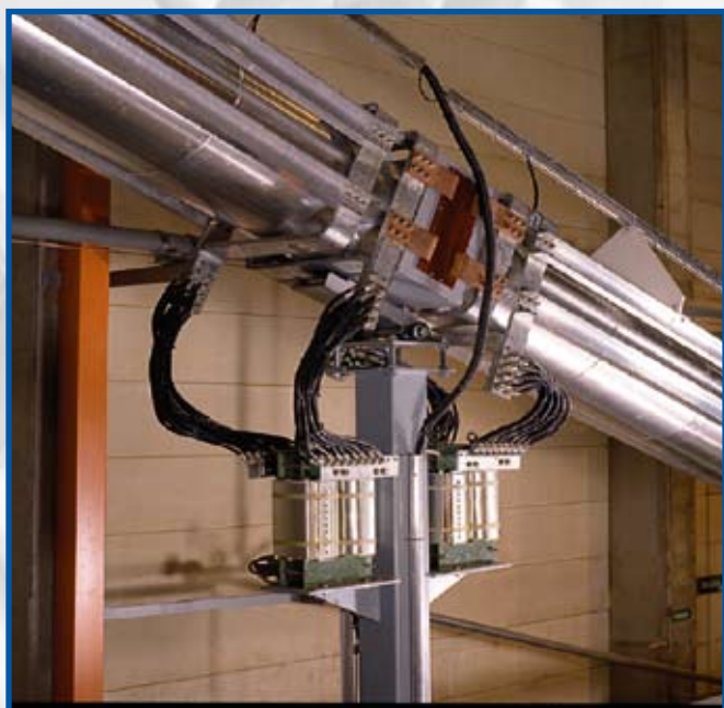
Рис. 3. Система прямого нагрева трубы вулканизации
