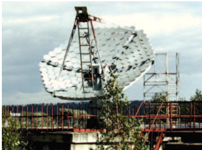
Рис. 5. Солнечная установка с металлическими зеркалами и двигателем Стирлинга, 1995 г.
