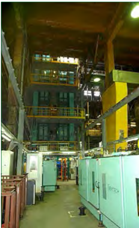
Вертикальный эмальагрегат, установленный на заводе Камкабель
