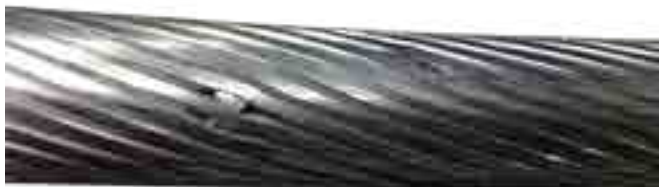
Рис. 3. Обрыв и сварка проволок токопроводящей жилы
