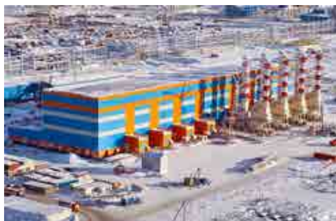
Рис. 10. Строительство завода по сжижению природного газа проекта «Ямал СПГ». Фото с сайта ПАО «НОВАТЭК». http://www.novatek.ru
