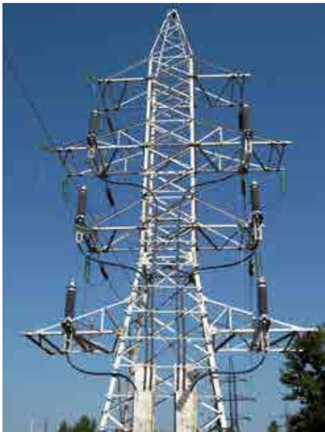
Рис. 4. Концевые муфты АРЕСВ 1452 Р на опоре ВЛ. Казань, 2008 г.
