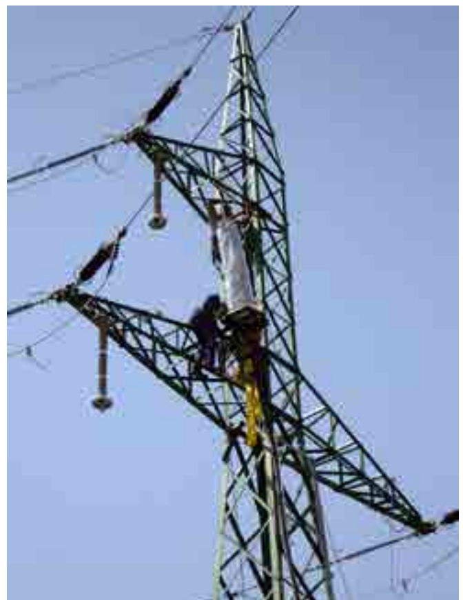
Рис. 15. Установка КМ с металлоконструкцией на место расположения на опоре ВЛ
