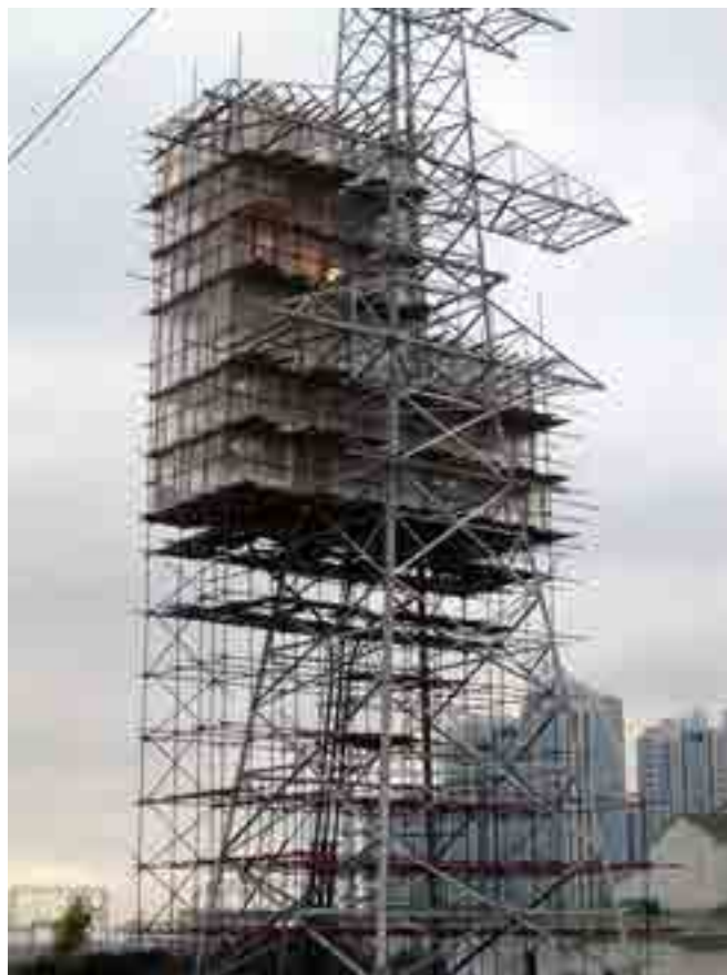
Рис. 2. Временное помещение для монтажа концевых муфт ЕНFVC 145 на опоре ВЛ 110 кВ
