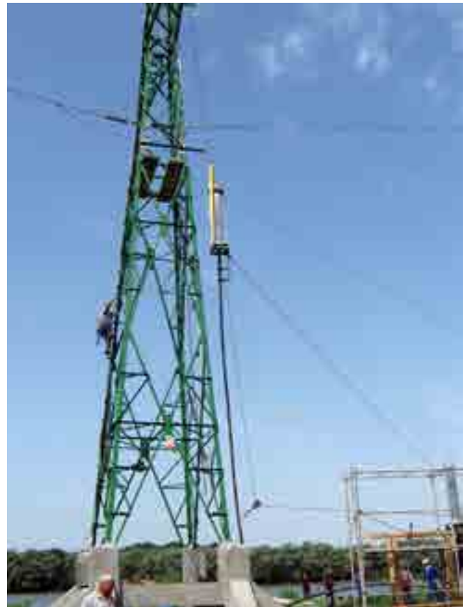
Рис. 14. Подъём КМ и кабеля, закреплённых на металлоконструкции, на опору ВЛ
