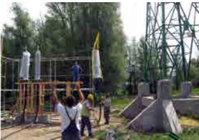
Рис. 13. Строповка КМ и кабеля, закреплённых на металлоконструкции
