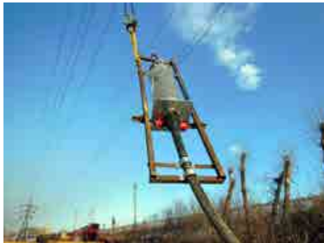
Рис. 6. Крепление МКВ 126 и кабеля на приспособлении, соединение приспособления с крюком подъемного крана с помощью стропа
