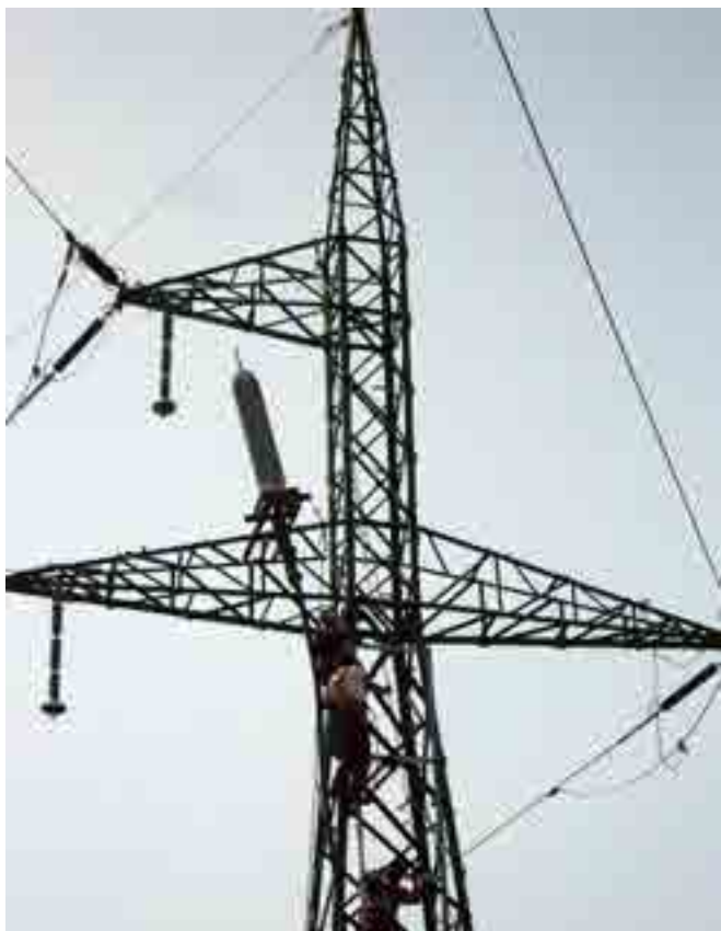
Рис. 16. Закрепление кабеля хомутами на опоре ВЛ
