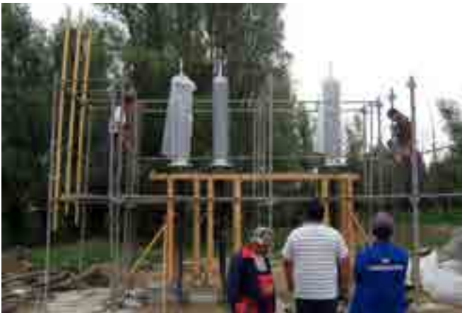
Рис. 12. Концевые муфты, смонтированные на земле, закреплённые вместе с кабелями на металлоконструкциях
